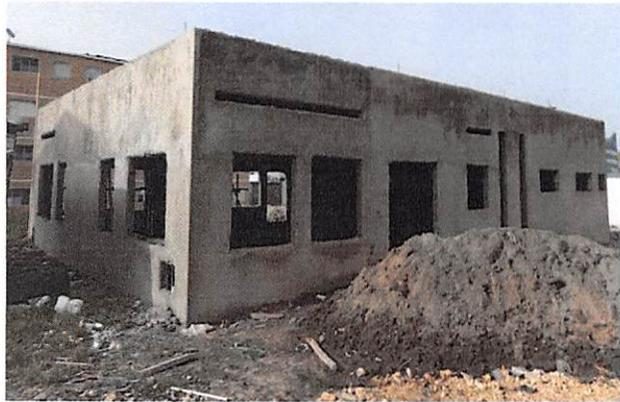
Esta obra se construye en estructura de hormigón armado y muros de bloques. La misma posee un área aproximada de 240 metros cuadrados y se estima que beneficiará alrededor de 10, 000 familias.
